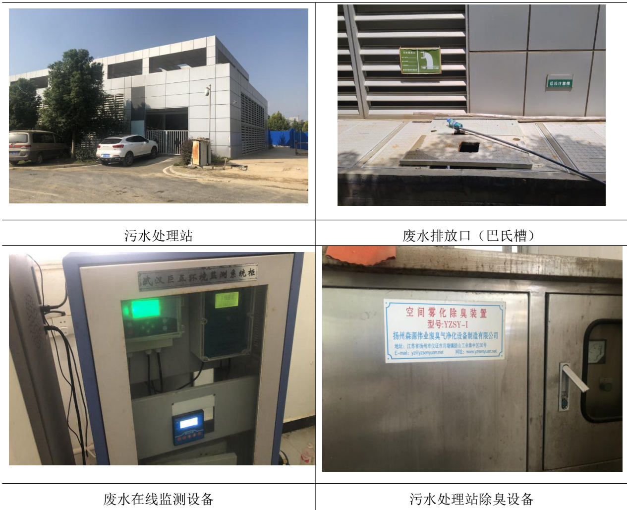
图 2-3-3 污水处理站现状图
