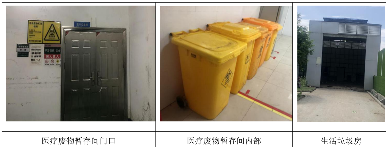
图 2-3-4 医疗废物暂存间现状图
